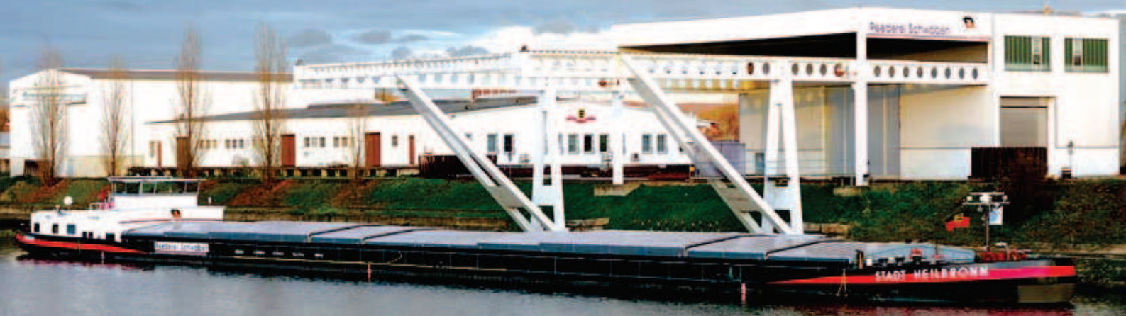
Das reedereieigene Schiff STADT HEILBRONN vor der trimodalen Umschlagsanlage im Hafen Heilbronn
